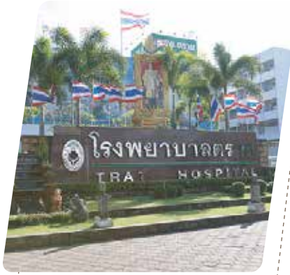
ชื่อโครงการ : อาคารผู้ป่วยพิเศษ สกลมหาสังฆปริณายกที่ 15 รพ. ตราด จังหวัด : ตราด Type : PP Mechanical joint
