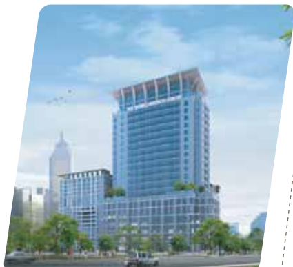
ชื่อโครงการ : The World medical Center รพ. เกษมราษฎร์ จังหวัด : กรุงเทพมหานคร Type : PP Mechanical joint
