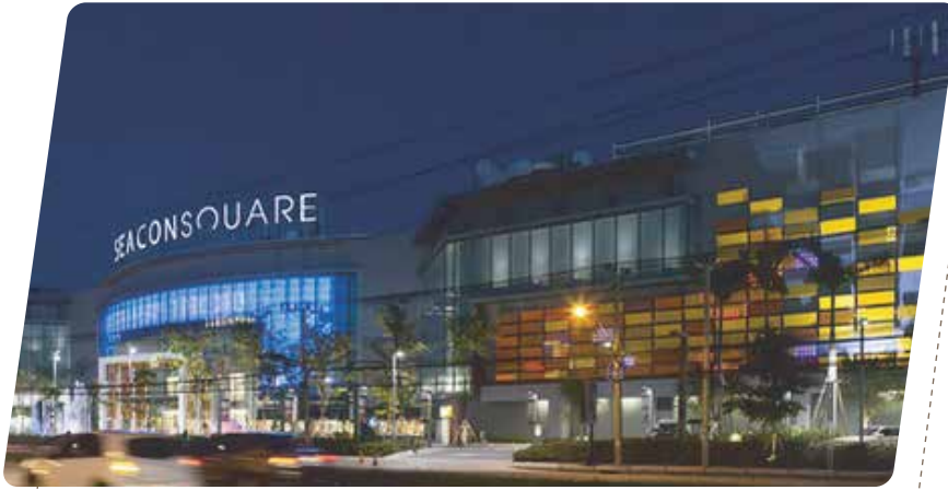
ชื่อโครงการ : Seaconsquare จังหวัด : กรุงเทพมหานคร Type : PP Mechanical joint
