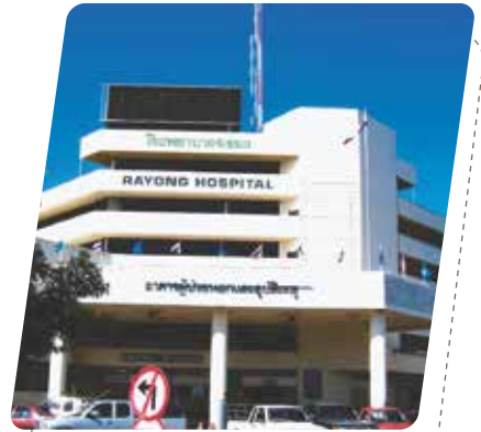
ชื่อโครงการ : อาคารบริการ รพ. ระยอง จังหวัด : ระยอง Type : PP Mechanical joint
