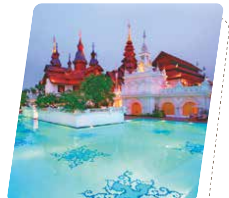
ชื่อโครงการ : โรงแรมแมนดาริน โอเรียนเต็ล ดาราเทวี จังหวัด : เชียงใหม่ Type : PP Mechanical joint
