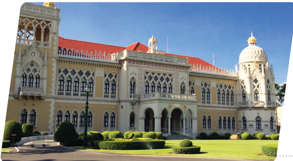
ชื่อโครงการ : Landscape ทำเนียบรัฐบาล จังหวัด : กรุงเทพมหานคร Type : ท่อ Neodrain
