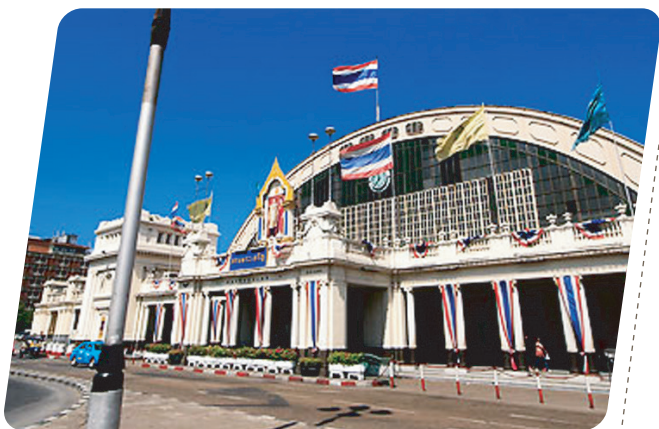
ชื่อโครงการ : ปรับปรุงสถานีหัวลำโพง จังหวัด : กรุงเทพมหานคร Type : ท่อ Neodrain
