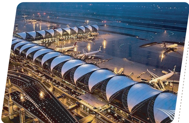
ชื่อโครงการ : สนามบินสุวรรณภูมิ จังหวัด : กรุงเทพมหานคร Type : ท่อ Neodrain
