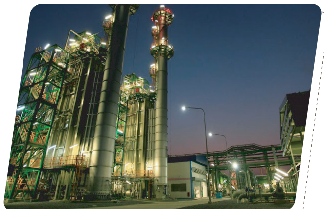
ชื่อโครงการ : โรงไฟฟ้า นวนคร จังหวัด : ปทุมธานี Type : ท่อ Neodrain
