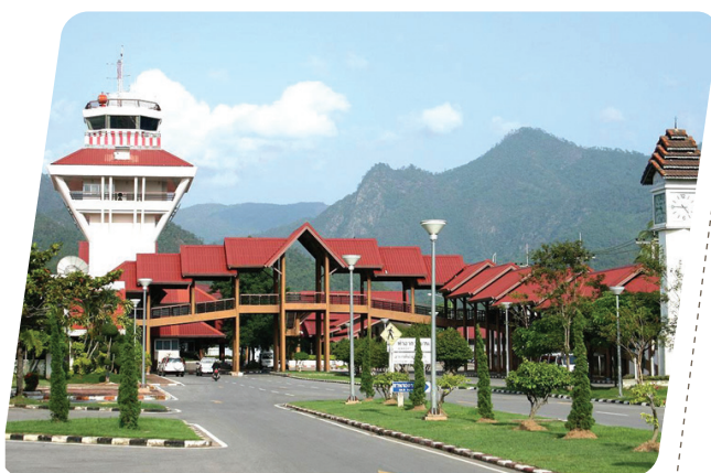
ชื่อโครงการ : สนามบินแม่ฮ่องสอน จังหวัด : แม่ฮ่องสอน Type : ท่อ Neodrain
