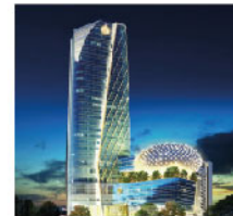
สำนักงานการไฟฟ้านครหลวง Metropolitan Electricity Authority
