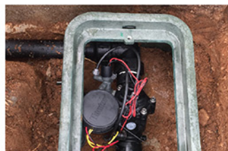
2. ติดตั้งชุดวาล์วระบบบายน้ำอัตโนมัติ
