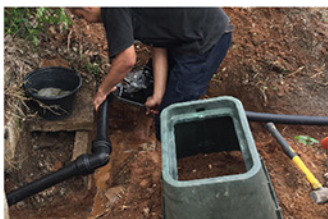
1. ขุดหาตำแหน่งท่อและจุดติดตั้ง
